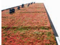
gröna tak för temperaturutjämning (och infiltration av dagvatten)
