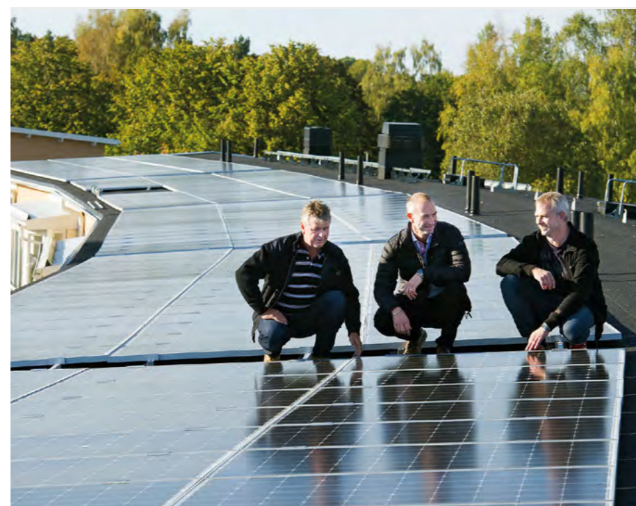
Brf Nyköpingshus 15 i Nyköping med regionens största solcellsanläggning.
